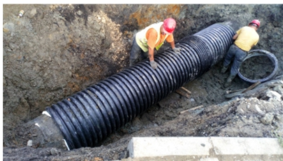
Budowa kanalizacji sanitarnej w ulicy Brzozowej – sierpień 2018 r. Fot. Andrzej Ryska
